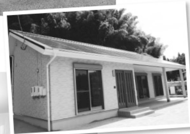
平層の大屋根に太陽光発電。20年間安心の売電収入。
