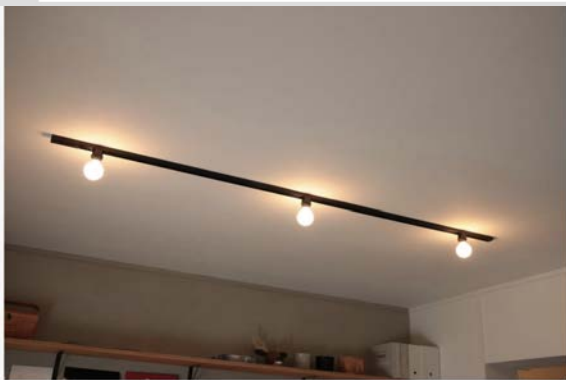
ソケットプラグを使って電球をつけた例。(E26ソケット(BK))
